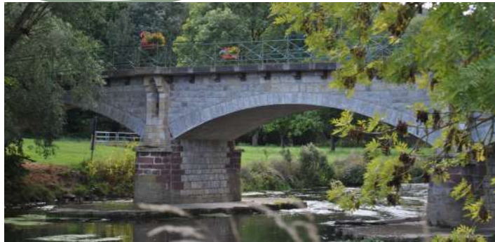
Quelle: Brückensanierung mit Hilfe LEADER (Quelle: Sweco GmbH)
